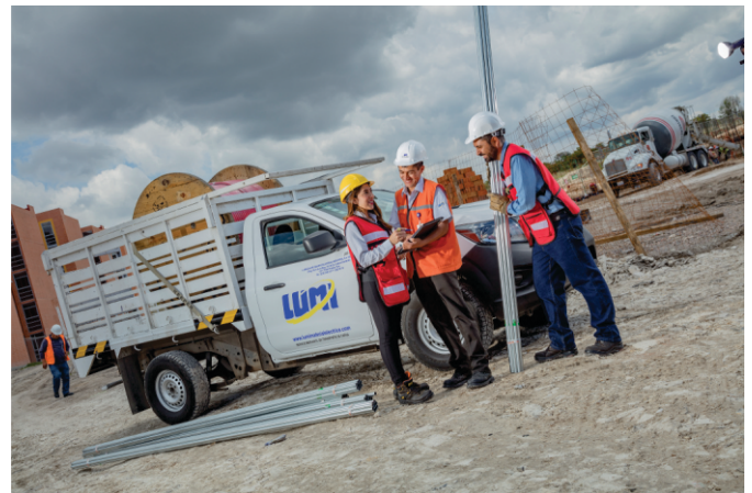
Visitas en obra
